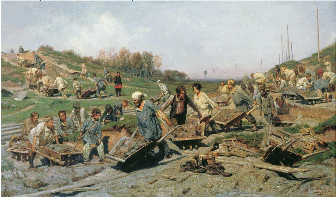
«Ремонтные работы на железной дороге». К. А. Савицкий ссылка
